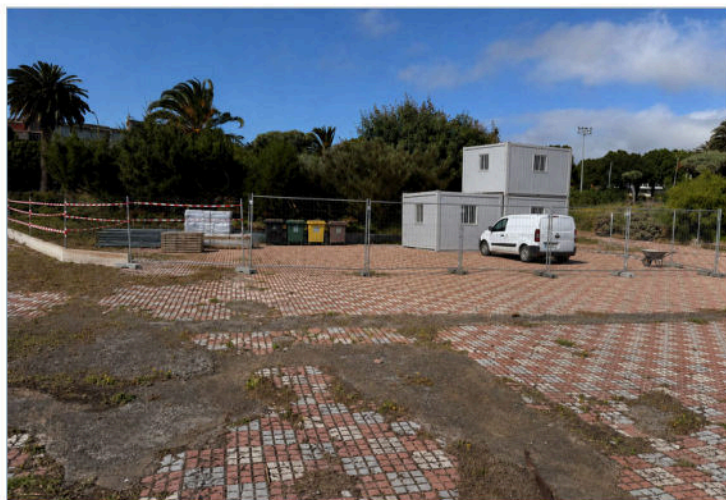
Fig. 2 - La ZIA-1 en la explanada de la ULL, separada del edificio: recinto vallado con casetas, oficina, punto limpio y acopio de baja rotación, con el jardín endémico balizado.
