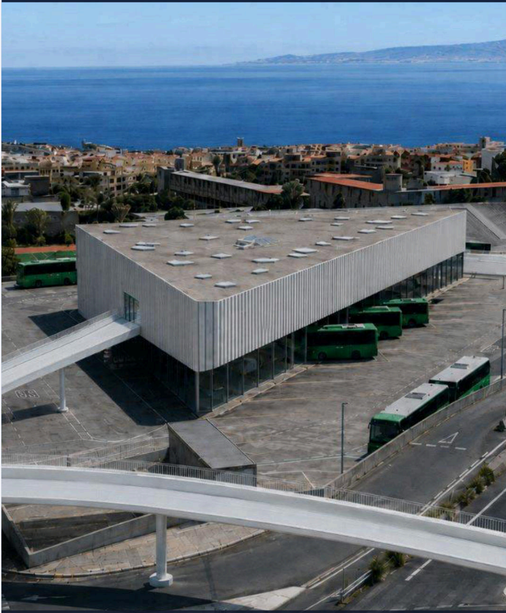
Intercambiador terminado sobre el frente marítimo
