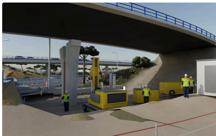
Figura 1.10. Recalce de P2 desde el este. Izquierda: micropilotadora de gálibo reducido en la plataforma este, bajo el tablero existente, con el arcén de la MA-20 libre. Derecha: pista de acceso y plataforma sobre ortofoto, planta del encepado con los 8 micropilotes y su orden de ejecución, y secuencia del programa.
