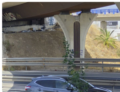
Figura 1.5. Visita de 01/09/2026. Tablero curvo del ramal sobre la MA-20 en servicio; pila P2 junto a la bionda de la MA-20 con el terraplén del E2 existente al fondo; cargadero del E2 existente con las chapas de recrecio sobre los apoyos.
