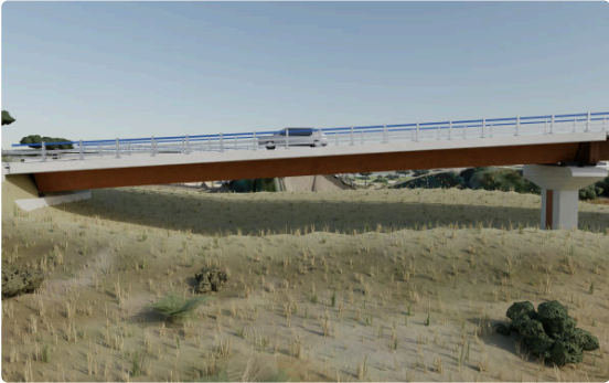
Figura 1.16. Vano 4 terminado: cajón de acero patinable, losa de 10,80 m y pretil H3; NE2 con relleno de 4,00-4,50 m.
