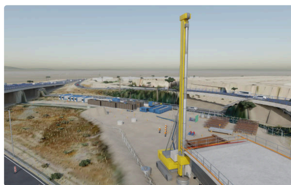
Figura 1.11. Campaña de pilotes Ø1,80 m en P3 con la planta de lodos y el taller de jaulas; P2 ya recalzado.
