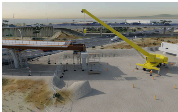
Figura 1.13. Encepado de P3 terminado y torres de apeo cargando el vano 3 antes de demoler el cargadero antiguo.
