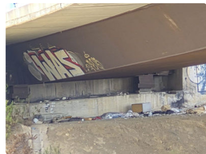
Figura 1.5. Visita de 01/09/2026. Tablero curvo del ramal sobre la MA-20 en servicio; pila P2 junto a la bionda de la MA-20 con el terraplén del E2 existente al fondo; cargadero del E2 existente con las chapas de recrecio sobre los apoyos.
