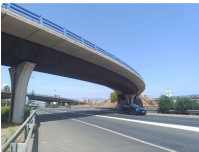
Figura 1.5. Visita de 01/09/2026. Tablero curvo del ramal sobre la MA-20 en servicio; pila P2 junto a la bionda de la MA-20 con el terraplén del E2 existente al fondo; cargadero del E2 existente con las chapas de recrecio sobre los apoyos.
