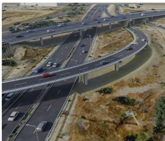
Figura 1.1. Obra terminada. Vista aérea del ramal MA-21→MA-20 ampliado: vano 4 en cajón de acero patinable sobre la nueva pila P3 y el nuevo estribo NE2, con el terraplén que cargaba el antiguo E2 ya retirado.
