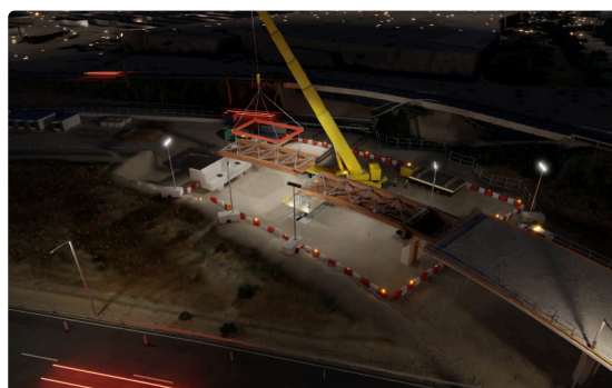
Figura 1.14. Montaje nocturno del vano 4: tramo 1 ya apoyado en P3 y en la cimbra intermedia; el tramo 2, izado por la grúa de 250 t de la plataforma interior; área de exclusión balizada y MA-20 en servicio.
