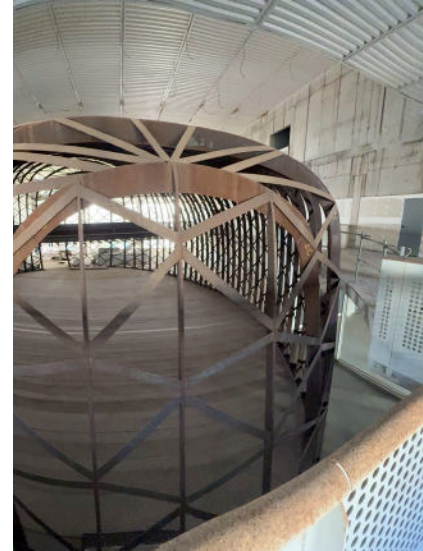
Figura 21. Interior del ovoide: tarima ancha de madera y costillas de corten con su celosía de pletinas. Antes de montar el andamio interior, la tarima se cubrirá con tableros de reparto y ningún pie de andamio apoyará directamente sobre ella ni sobre las costillas.
