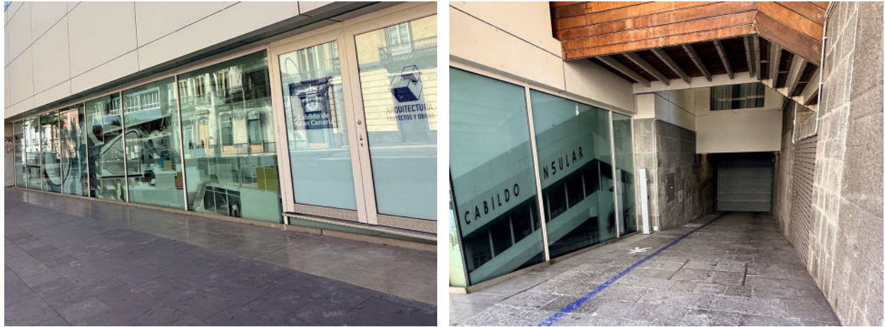
Figura 1.6. Frente de C/ Bravo Murillo: a la izquierda, la fachada protegida, con la planta baja a nivel de acera y sin escalón, que no recibirá cargas ni anclajes; a la derecha, la boca de la rampa del garaje de consejeros, que quedará siempre libre.
