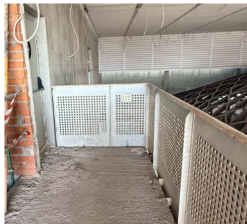
Figura 2.2. Pasillo de la entreplanta junto al ovoide, con la barandilla perforada de De la Sota, que se protegerá y no recibirá apoyos ni anclajes de los medios auxiliares.
