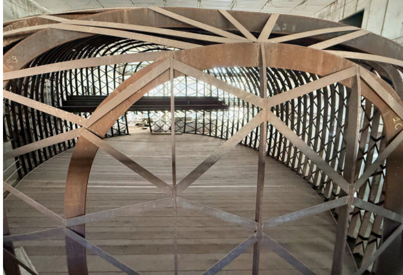
Figura 21. Interior del ovoide: tarima ancha de madera y costillas de corten con su celosía de pletinas. Antes de montar el andamio interior, la tarima se cubrirá con tableros de reparto y ningún pie de andamio apoyará directamente sobre ella ni sobre las costillas.
