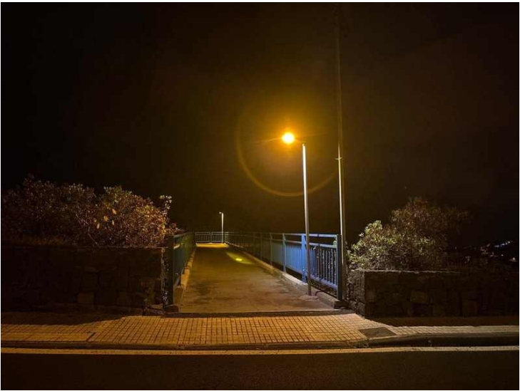
L2-A10-F07 · Punto de tono ámbar intenso operativo junto a senda peatonal; barandillas metálicas con pintura conservada · GPS 28.464425, -16.439425
