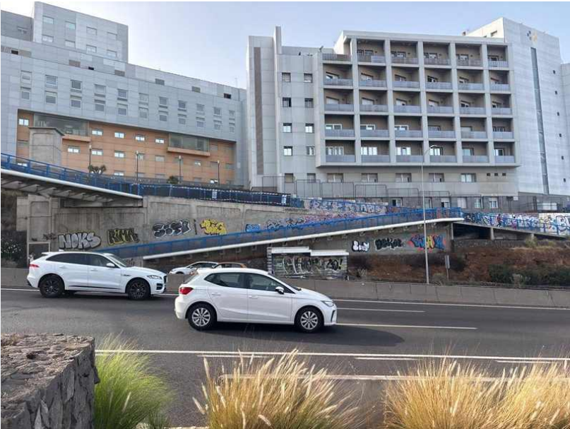
L2-A01·F03 · Columna recta con luminaria vial en la margen de la trinchera, sin desplome aparente; caseta al pie del talud con pintadas, titularidad por verificar · GPS 28.447600, -16.283689
