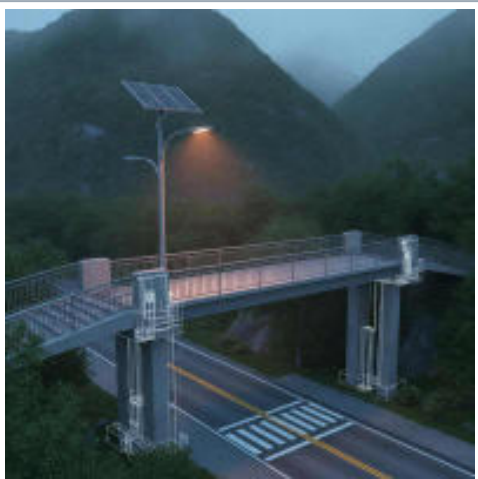
Paso de peatones con conjunto solar autónomo: verificación nocturna de la ronda de N6
