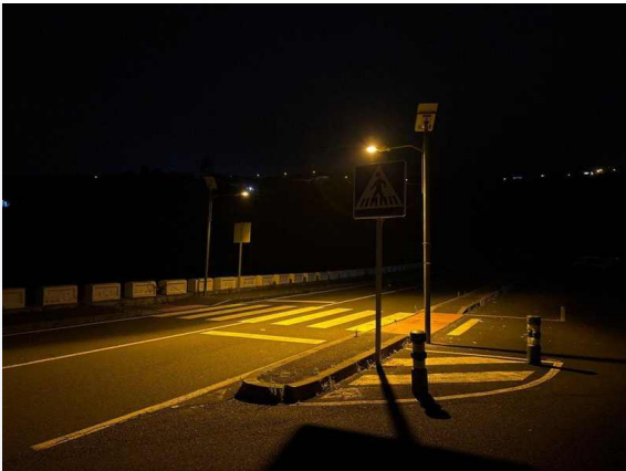
L2-P03-F01 · Paso TF-373: conjunto solar encendido con emisión ámbar concentrada en el cebreado; segundo punto operativo al fondo · GPS 28.360473, -16.732396
