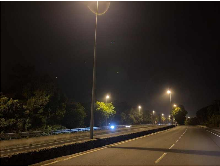
L2-A10-F08 · Doble calzada interurbana: secuencia continua de al menos seis puntos encendidos en margen y mediana, uniformidad aparente razonable · GPS 28.487934, -16.382059
