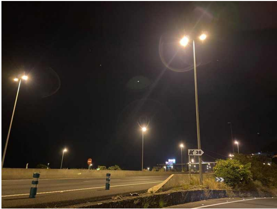
L2-A11-F02 · Columna con disposición doble encendida y puntos escalonados en tronco y ramales; pasarela atirantada iluminada al fondo · GPS 28.392913, -16.566091
