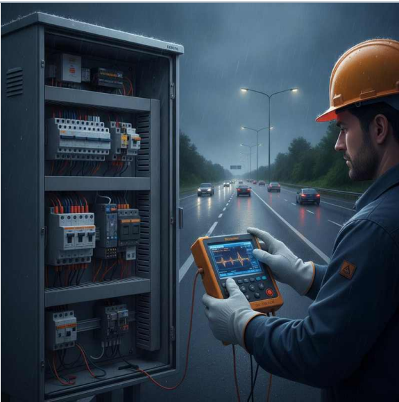
Revisión semestral de centro de mando: medida, termografía y acta
