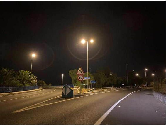
L2-A11-F16 · Bifurcación del enlace: todos los puntos visibles encendidos, iluminación aparente suficiente de la divergencia · GPS 28.397367, -16.528664
