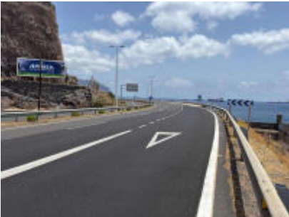
L2-A15-F07 · Campaña diurna: tipologías, soportes y obra civil (TF-11) · GPS 28.500012, -16.195929
