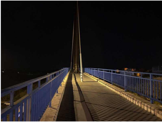
L2-A11-F08 · Pasarela: nivel aparente bajo y desigual sobre el tablero, zona del mástil en penumbra; grafiti moderado en la base del mástil · GPS 28.393411, -16.564069
