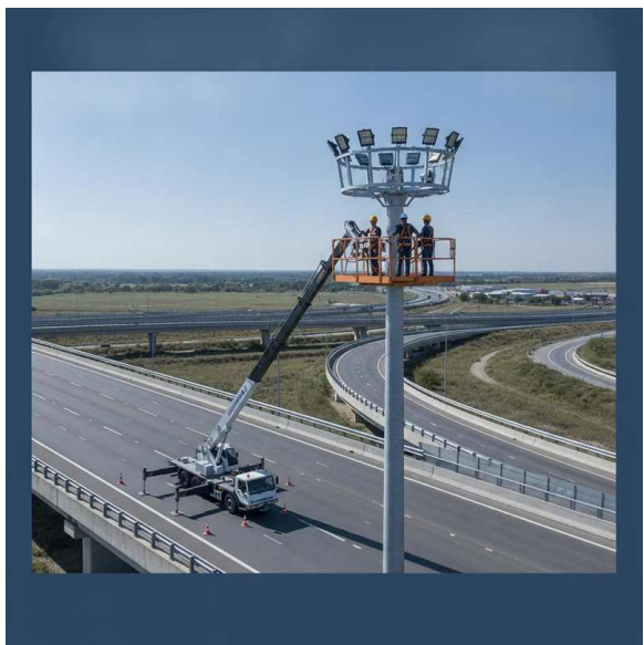
Acceso a corona de torre de gran altura: arnés, anemómetro y zona de exclusión
