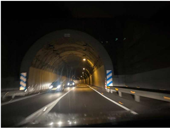
L2-CM12-01-F01 · Túnel de San Vicente: puntos cálidos espaciados encendidos y refuerzo de embocadura sin encender (toma en marcha) · GPS 28.392688, -16.591252
