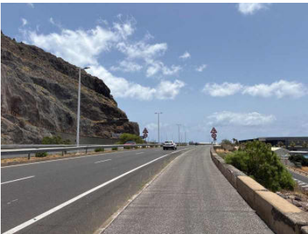
Alineación de columnas con doble luminaria en T en la mediana de la TF-11, vista hacia Santa Cruz · L2-A15-F08
