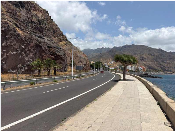
L2-A15-F04 · TF-11: columnas de fibra de vidrio blancas en mediana con doble luminaria en T, verticales y limpias · GPS 28.503439, -16.192627
