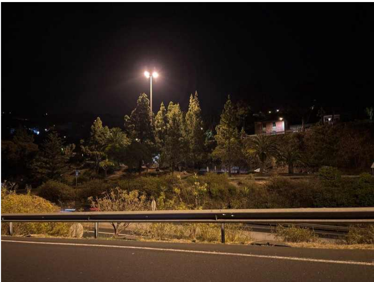
L2-A10-F04 · Enlace: dos proyectores encendidos en cabeza de columna; resto del entorno de la glorieta en penumbra, con puntos dispersos lejanos · GPS 28.459693, -16.449095
