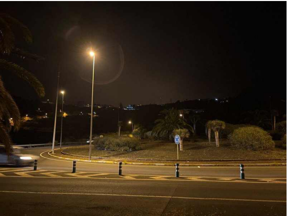
L2-CM21-01-F01 · Rotonda de Buen Paso: puntos en servicio con iluminación concentrada junto a los soportes y penumbra en el resto del anillo · GPS 28.382343, -16.677585
