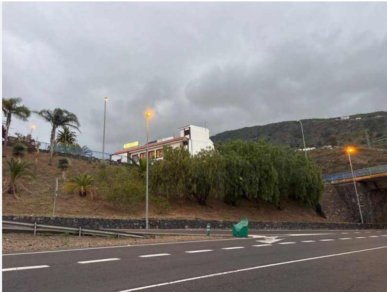
L2-A19-F03 · Icod: encendido crepuscular efectivo, con al menos cuatro luminarias operativas en ambas márgenes y junto al paso inferior · GPS 28.370465, -16.724180
