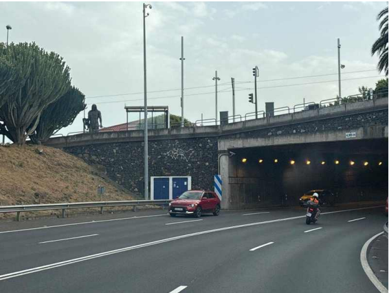
L2-A16-F10 · Paso inferior con dos hileras de puntos de tono ámbar encendidas en toma crepuscular; envolvente con señal de riesgo eléctrico junto al portal · GPS 28.475606, -16.307717
