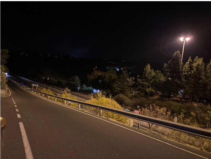
L2-A10-F05 · Ramal en descenso: dos puntos encendidos de tono cálido; la interdistancia deja zonas oscuras aparentes en el resto del tramo · GPS 28.459693, -16.449095
