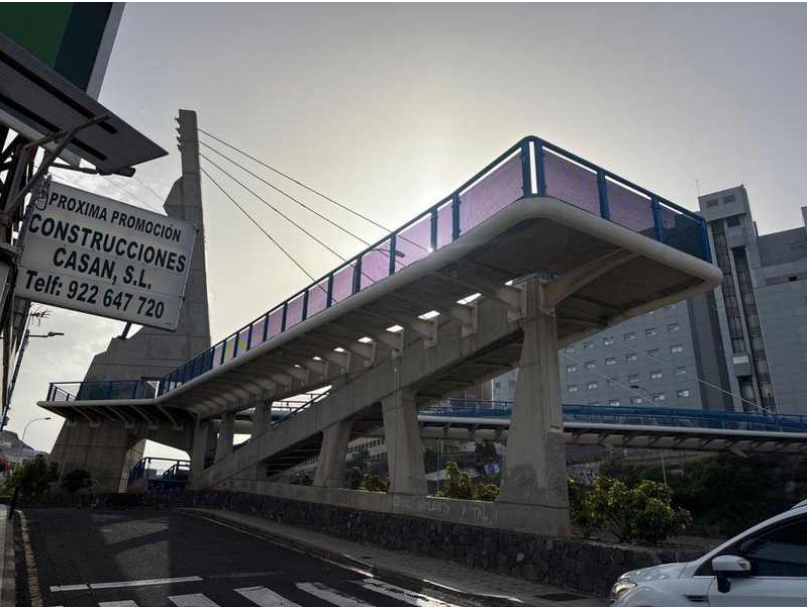
L2-A01·F01 · Pasarela atirantada del corredor metropolitano: pintura en aparente buen estado; grafitis en zócalo, estribo y pilas (toma diurna, instalación apagada por horario) · GPS 28.447574, -16.283611
