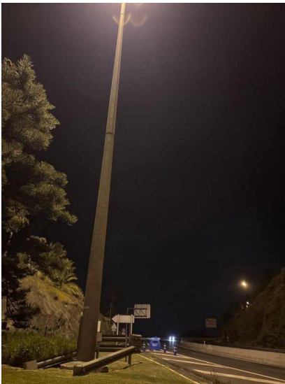
L2-A10-F02 · Columna de gran altura junto a ramal con el punto encendido en cabeza; base sin daños aparentes; berma ajardinada segada · GPS 28.469431, -16.433747
