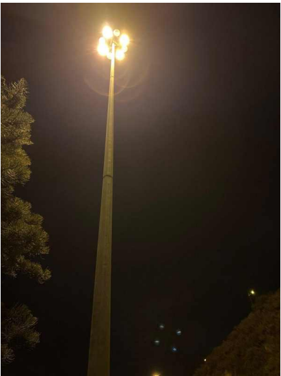
L2-A10-F01 · Torre de gran altura: corona de al menos seis proyectores encendida, luz cálida de apariencia VSAP; junta de fuste visible, sin desplome aparente · GPS 28.469504, -16.433782
