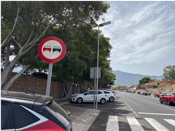
L2-P04-F02 · Paso TF-61: conjunto solar íntegro y sin corrosión; panel fotovoltaico parcialmente sombreado por el arbolado próximo · GPS 28.305774, -16.385126
