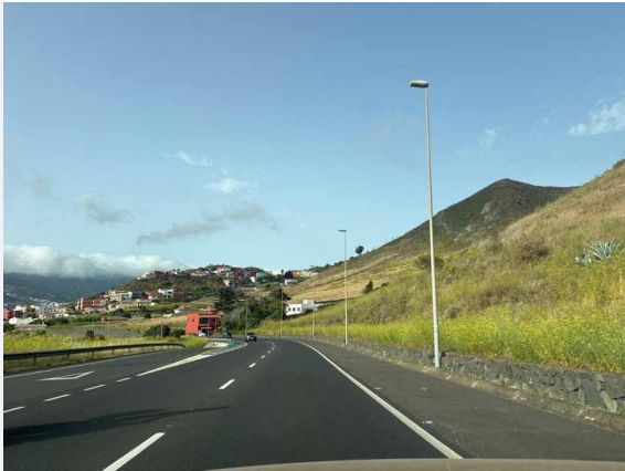
L2-A16-F02 · TF-13 Vía de Ronda: alineación de columnas galvanizadas de unos 12 m con luminaria vial cerrada; herbáceas altas junto a las bases · GPS 28.494884, -16.308393
