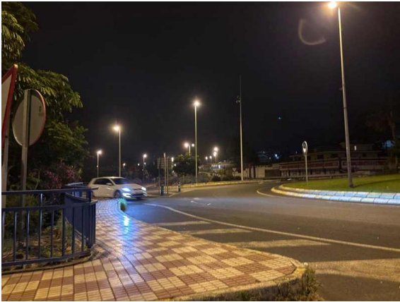
L2-A11-F01 · Columnas rectas galvanizadas con luminaria vial cerrada en punta, todas encendidas; apariencia razonable de uniformidad · GPS 28.391389, -16.579182
