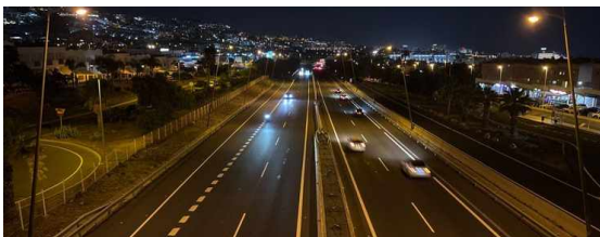
A08-F11 · Campaña nocturna: constatación de encendidos · GPS 28.092706, -16.729611
