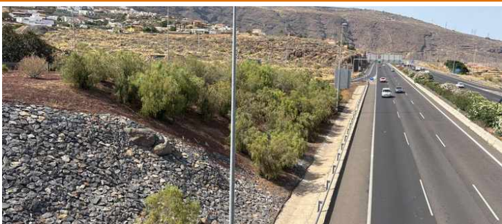
A03-F17 · Cableado/conducción tendido en superficie en berma y mediana — canalización del tendido · GPS 28.370843, -16.367568
