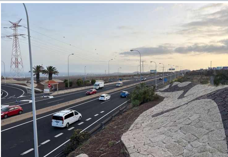
A06-F01 · Enlace Aeropuerto Sur: báculos 9-13 m con brazo curvo · GPS 28.058885, -16.580951
