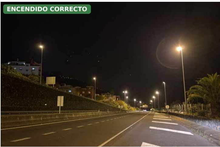
A03-F46 · 22:45 local: travesía encendida, tonos heterogéneos sodio/LED · GPS 28.391770, -16.579160
