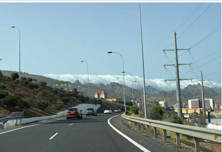
A03-F38 · Mezcla de tipologías: báculos curvos junto a columnas rectas · GPS 28.453492, -16.270756
