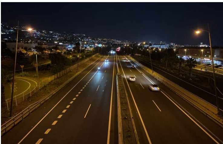
A08-F11 · Tronco TF-1 encendido, tono ámbar VSAP, uniformidad razonable · GPS 28.092706, -16.729611
