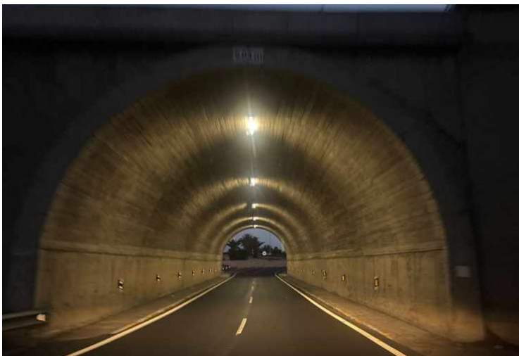
CM07-01-F01 · Paso inferior Guaza: alumbrado interior encendido y uniforme · GPS 28.053263, -16.678388
