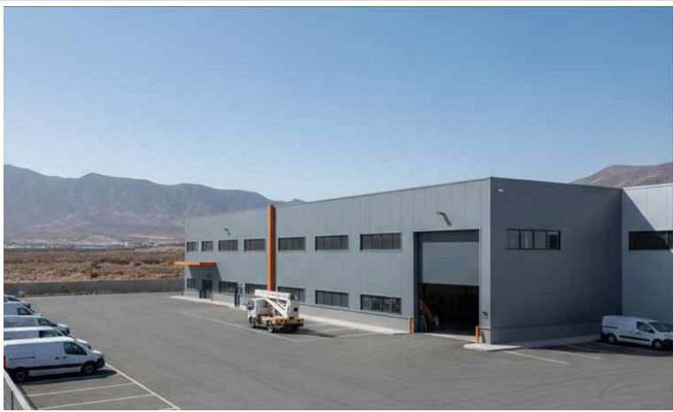
Nave del centro de conservación
