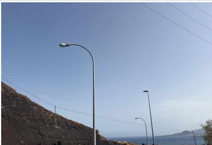
A03-F33 · Báculo de brazo curvo con óptica clásica tipo SAP · GPS 28.395003, -16.342990
