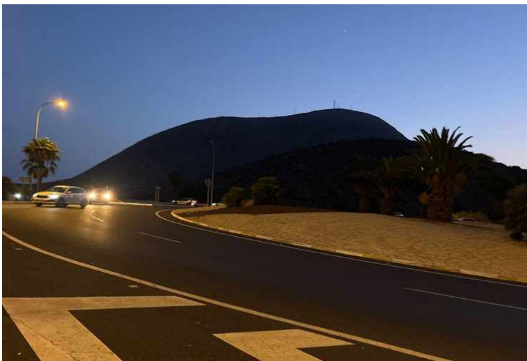
CM07-01-F03 · Glorieta de Guaza: punto apagado, frente en penumbra · GPS 28.052363, -16.678285
