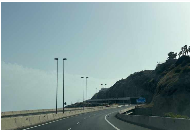
A10-F02 · Columnas pareadas en mediana hacia el túnel semiabierto · GPS 28.449002, -16.267800
