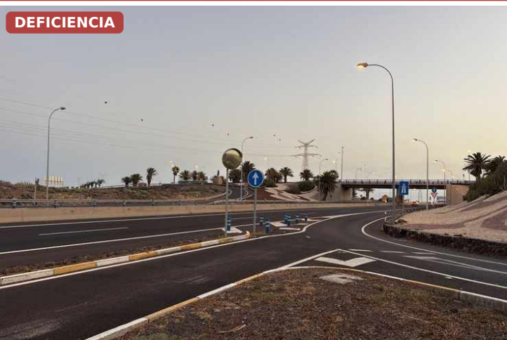
CM06-01-F09 · 21:12 local: encendido no homogéneo, columnas próximas apagadas · GPS 28.059431, -16.579699
