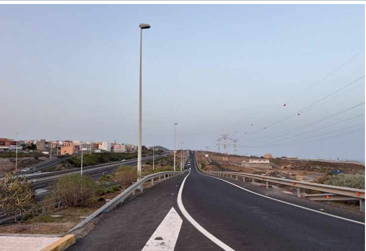
A05-F16 · Columna troncocónica crema vertical, sin corrosión ni golpes · GPS 28.067889, -16.562020
