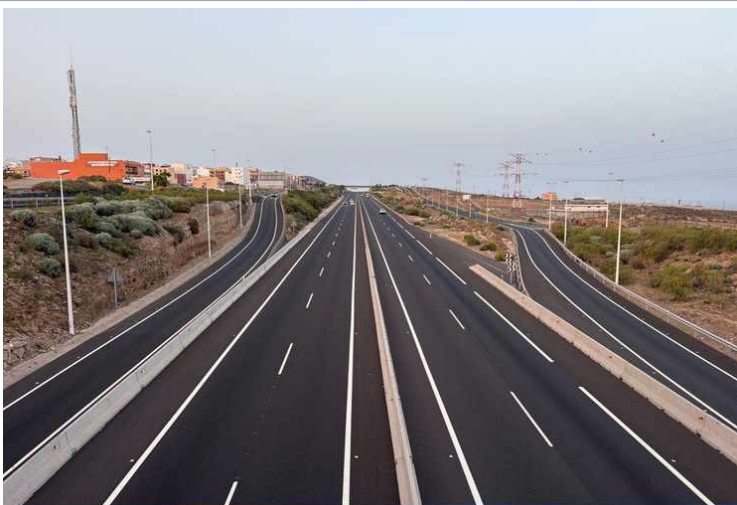
A05-F13 · Panorámica del tronco en San Isidro, sin incidencias visibles · GPS 28.068260, -16.562197
