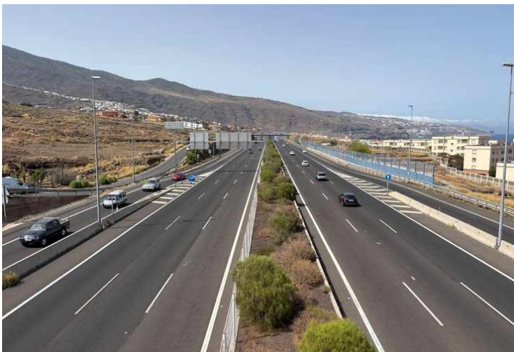
A03-F09 · Columnas en márgenes y ramales, verticales, porte homogéneo · GPS 28.360044, -16.371862
