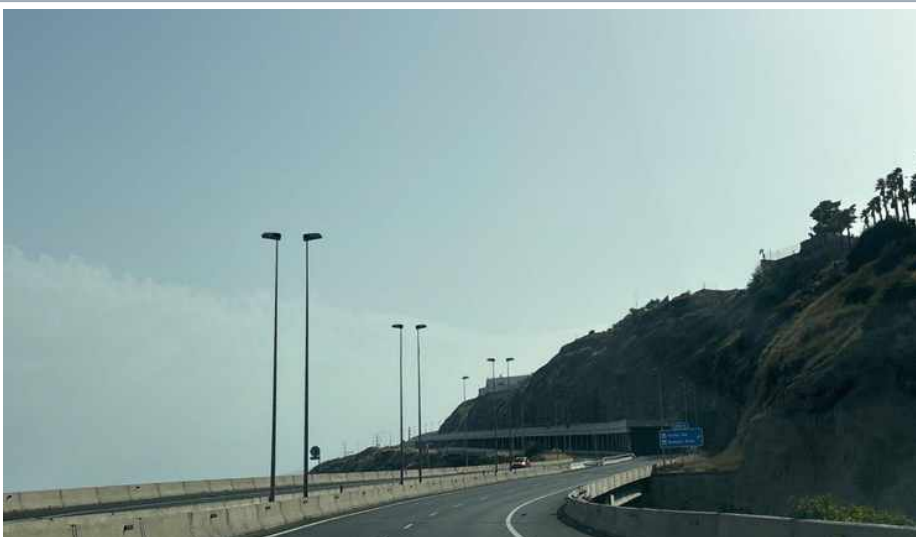
Columnas pareadas en mediana hacia el túnel semiabierto · L1-A10-F02 · 28.449002, -16.267800
