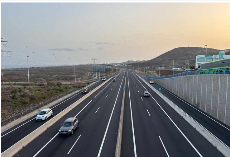
A05-F07 · Trinchera TF-1: columnas de gran altura en márgenes y ramales · GPS 28.068118, -16.562584
