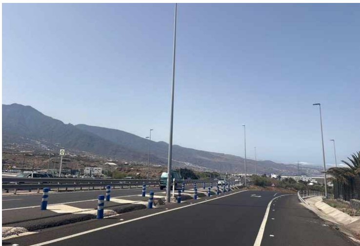
A03-F03 · Alineación en isleta: columnas rectas, luminaria cerrada, sin daños · GPS 28.329380, -16.375391
