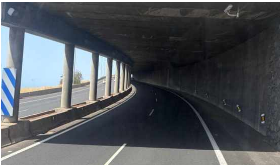
Boca del túnel TF-4: interior oscuro en toma diurna · L1-CT03-F01 · 28.432018, -16.292472
