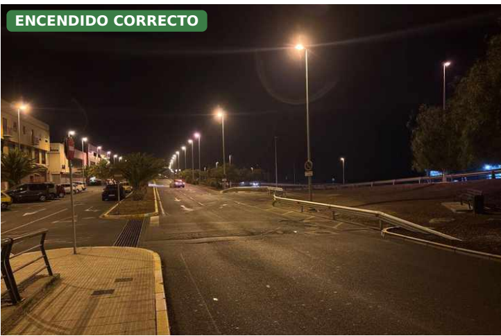
A05-F01 · 00:46 local: vía de servicio San Isidro encendida al completo · GPS 28.071341, -16.554582
