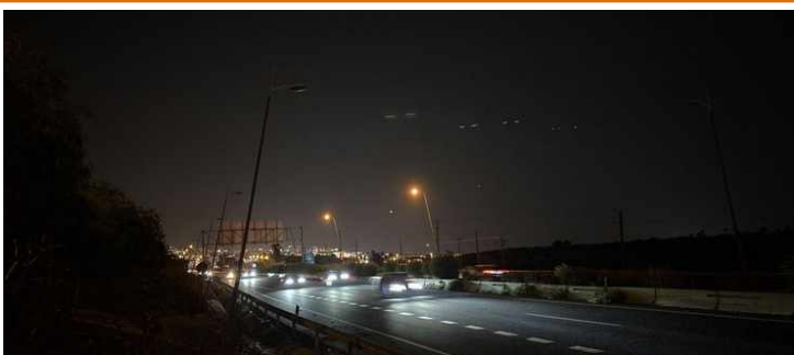
A08-F27 · Luminarias apagadas en secuencia nocturna con el resto encendido — reparación de avería · GPS 28.100286, -16.730645
