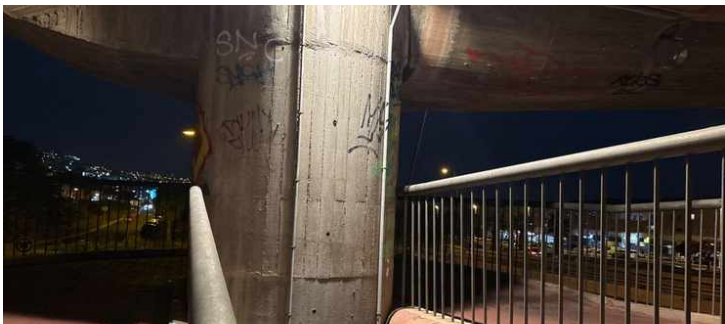
A08-F06 · Proyector descolgado suspendido del cableado — reparación urgente 24h · GPS 28.092797, -16.729341
