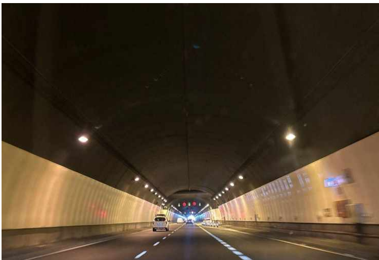
A03-F39 · Túnel: luminarias en hastiales encendidas, refuerzo hacia boca · GPS 28.458858, -16.257535
