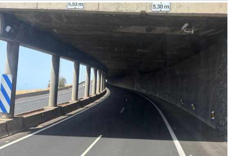
CT03-F01 · Boca del túnel TF-4: interior oscuro en toma diurna · GPS 28.432018, -16.292472
