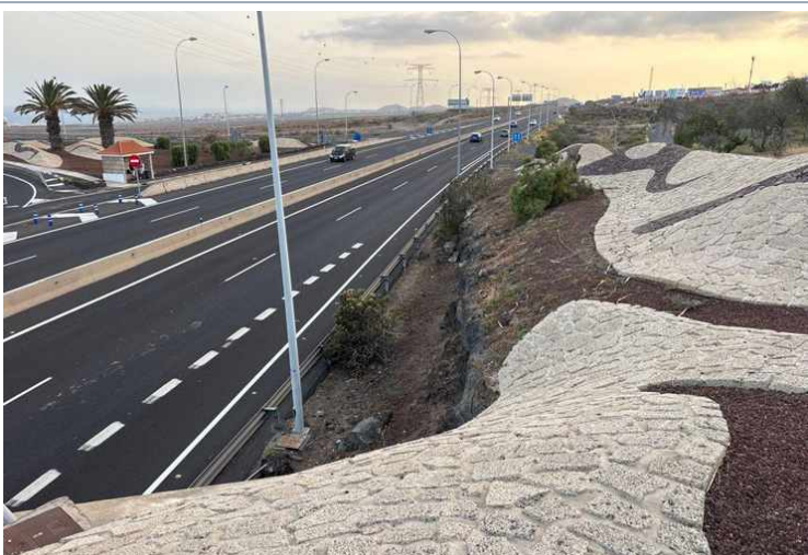
A06-F02 · Alineación regular de báculos tras bionda, fuste sin corrosión · GPS 28.058869, -16.580871
