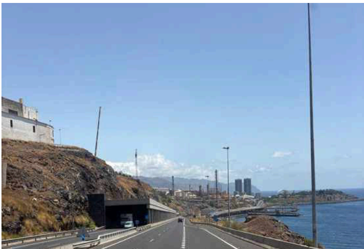
A03-F62 · Columna costera con luminaria LED plana, sin corrosión · GPS 28.448818, -16.267937
