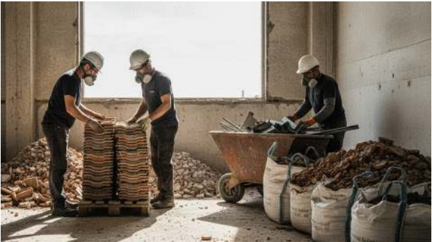
Demolición selectiva: cada material se separa en el propio tajo
