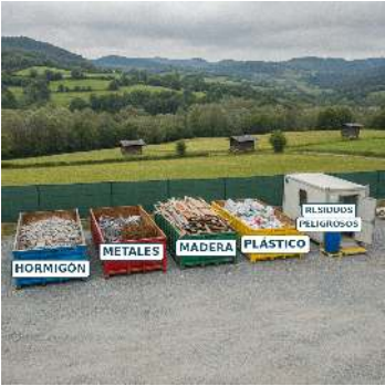
Punto limpio tipo en la ZIA: fracciones señalizadas y peligrosos sobre cubeto
