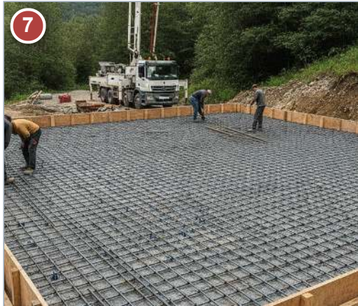
Losa HA-30 (hormigonado 2-9/09/2027): ferralla premontada, autorización de hormigonado (PP), puesta con bomba, vibrado, juntas según despiece y curado húmedo ≥ 7 días.
