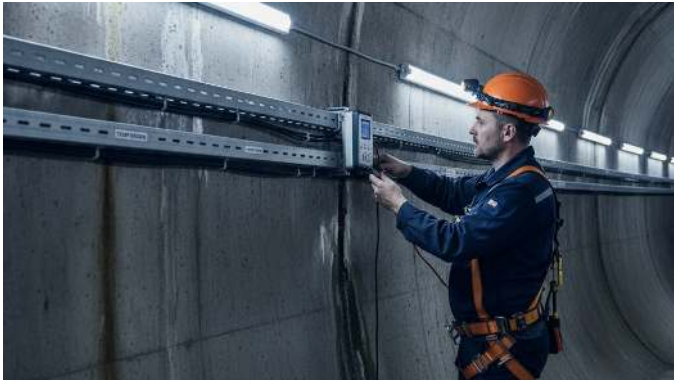
Instrumentación leyendo antes de las pruebas: el baseline de diciembre como criterio objetivo de aceptación
