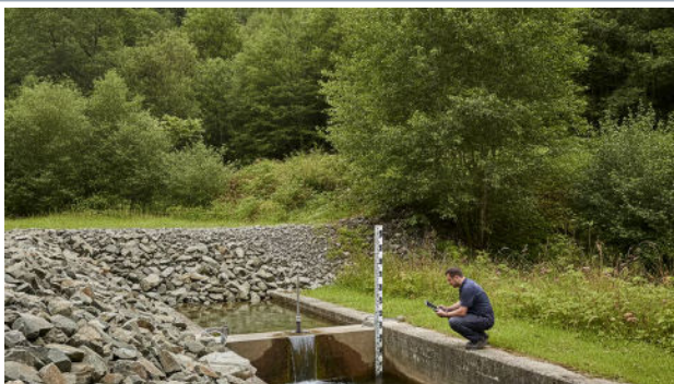
Aforador en V equipado: sensor + datalogger 4G
