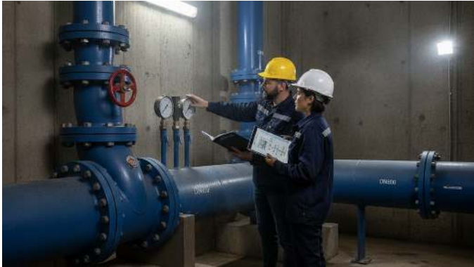
Prueba de estanqueidad bajo carga en la cámara de válvulas: presiones y tiempos registrados contra referencia
