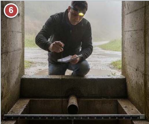
Verificación de estanqueidad (hito 23/09): apertura controlada del drenaje y comprobación de caudal remanente decreciente; reapriete o reposicionamiento si no estabiliza.
