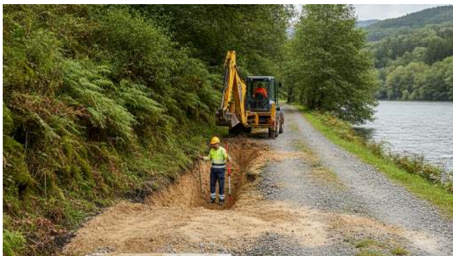
Restauración de cuneta 40x40 y ODT con miniexcavadora mixta
