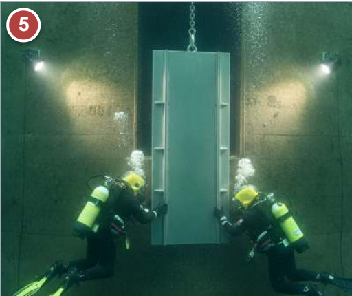
Instalación 1-22/09/2027: reconocimiento subacuático → retirada de rejilla → limpieza del marco → presentación con autogrúa y cabos guía → fijación de anclajes → compresión de junta.
