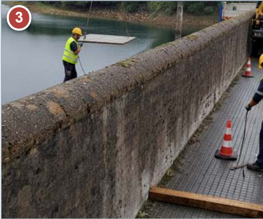
Transporte y acopio en coronación con ruta MO-5 reconocida y aviso previo; pieza sobre durmientes de reparto ( \leq 1,0 \text{ t/m}^2 ); plan de inmersión aprobado en agosto.
