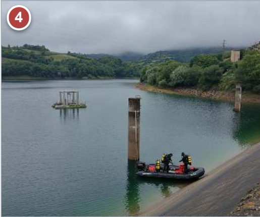
Condiciones previas: consigna de explotación; bloqueo LOTO del desagüe de fondo y de las bombas durante inmersiones; balizamiento, embarcación de apoyo y parte meteorológico.
