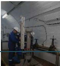
Premontaje en taller: spools AISI-304 con bridas y soldadura TIG con purga de argón; en cámara solo uniones de cierre
