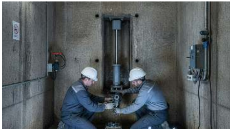
Sustitución de retenes con la vía gemela en servicio
