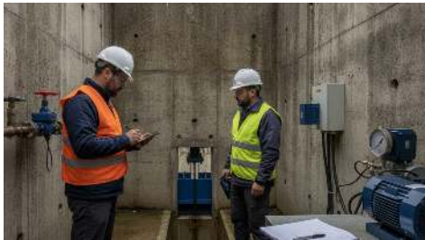
Protocolo de maniobras antes de retirar el aislamiento
