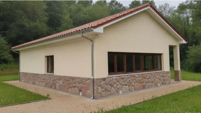
Estado final: envolvente rehabilitada y cubierta nueva a dos aguas; el edificio vuelve a ser el centro de control de la presa
