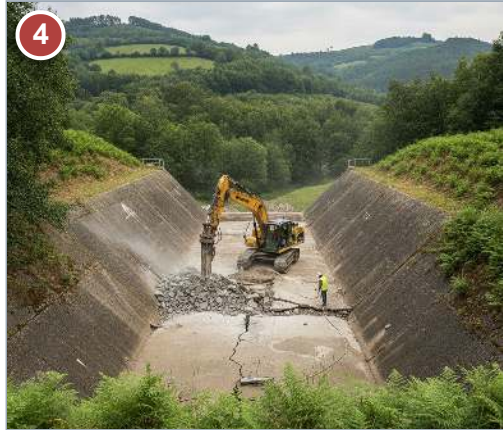
Demolición selectiva de la losa dañada (corte de juntas; hormigón a valorización) y excavación en caja por bataches (396 m³).
