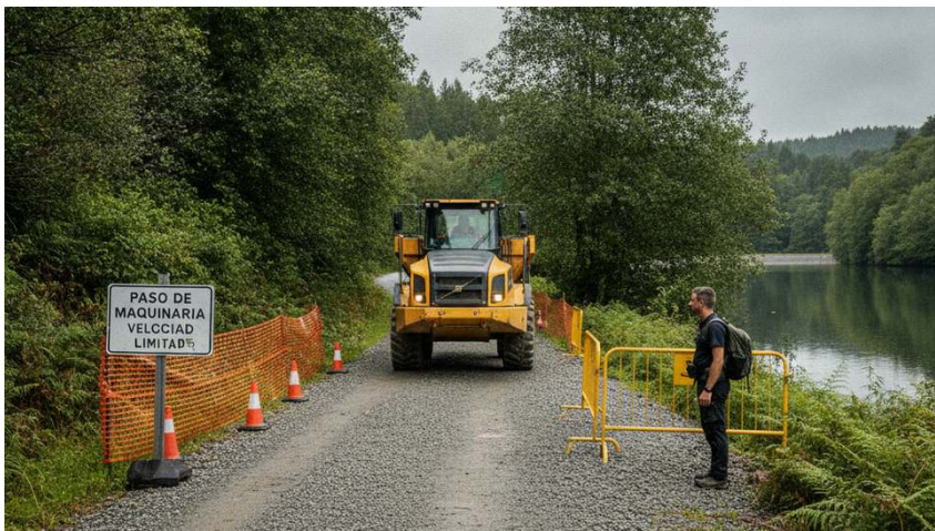
Balizamiento del camino perimetral con paso habilitado para senderistas: la senda no se corta, se ordena
