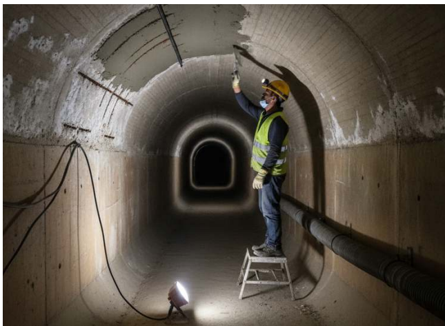
Pasivado y mortero R4 por capas en bóveda
