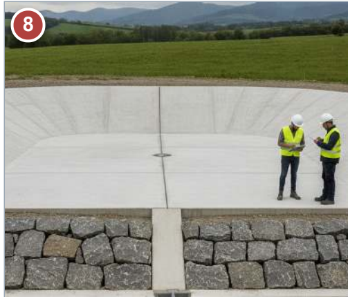
Zócalo de pie y escollera hormigonada (60 m³); retirada de accesos del cauce; prueba final e informe; en paralelo, el aforador (solución, obra civil e instrumentación).
