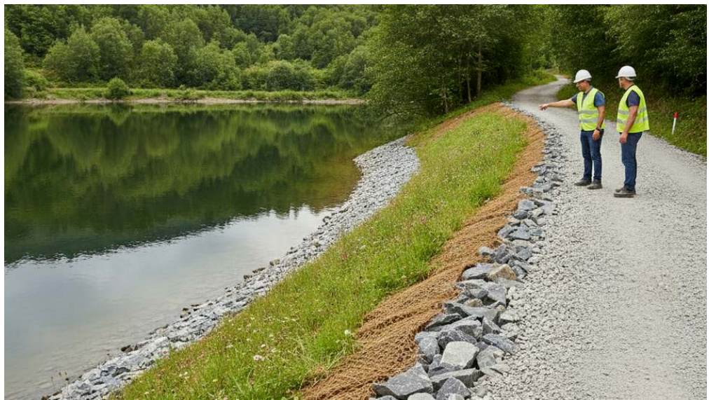
Estabilización del deslizamiento del P.K. 1+180: perfiles, malla y relleno drenante
