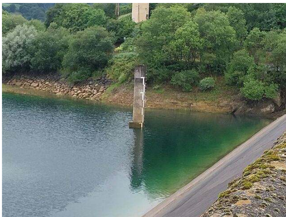
F02. Embalse y torre de toma: banda de resguardo visible (01/07/2026)
