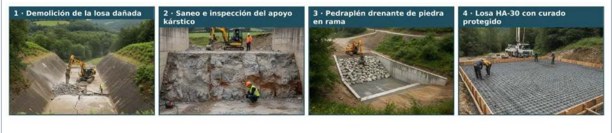
FIGURA 1.17. Secuencia del cuenco amortiguador: demolición, saneo kárstico, pedraplén drenante y losa HA-30.
