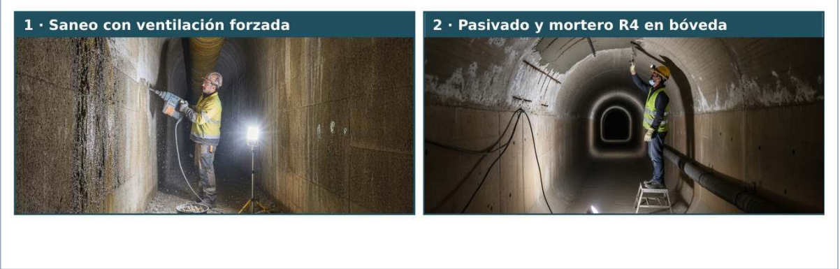
FIGURA 1.3. Secuencia de reparación en bóveda de galería: saneo con ventilación forzada, pasivado y mortero R4 (serie de ilustraciones genera
