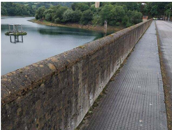
F01. Coronación: acera adoquinada aguas arriba y murete (43,2942 N; 5,9177 O)
