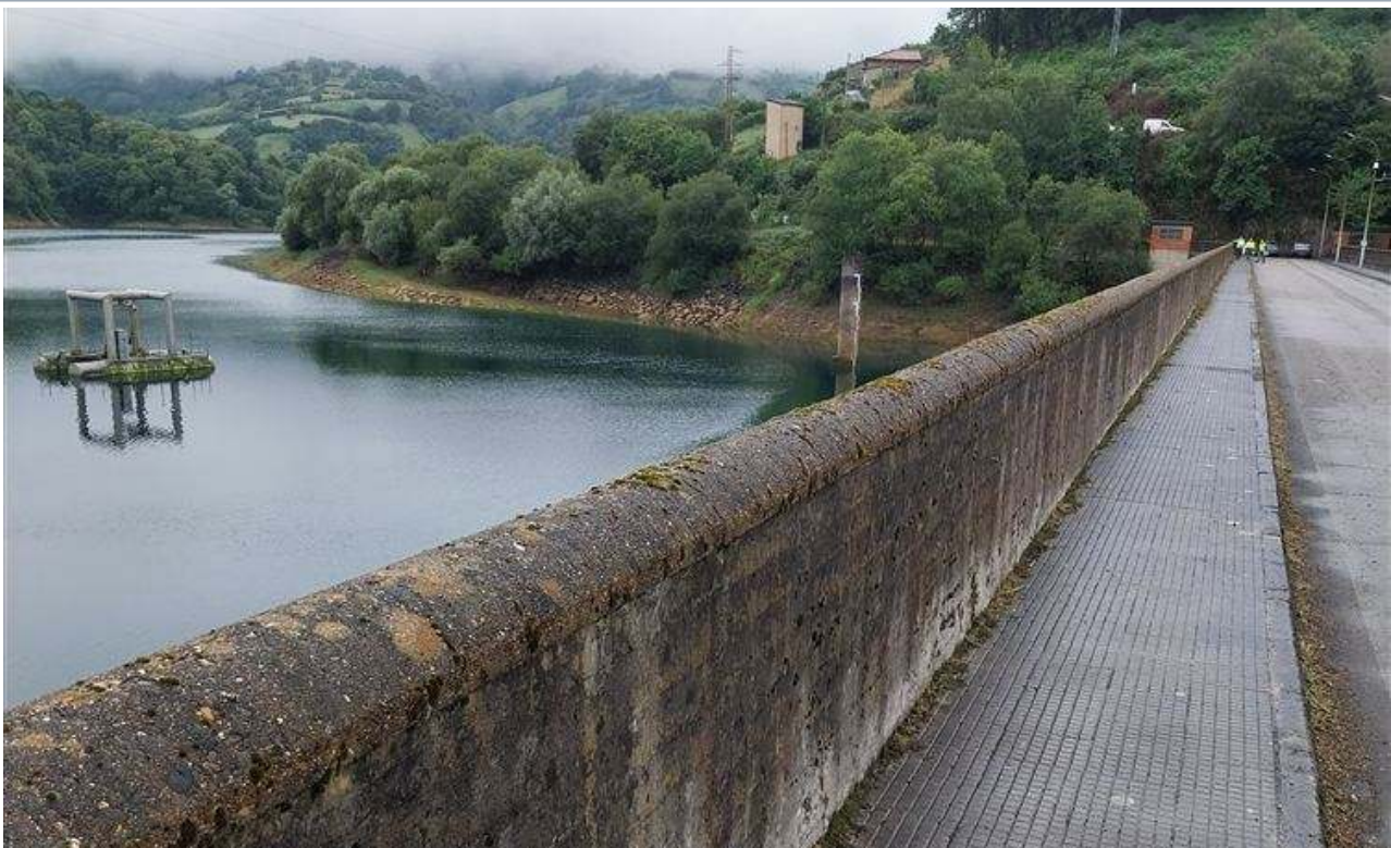
Camino de coronación con su pretil y la torre al fondo (visita 01/07/2026): las bases de colimación existentes soportan la auscultación geodésica
