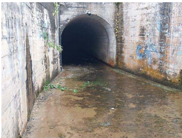
F12. Galería de trasvase de La Mortera con lámina de agua permanente
