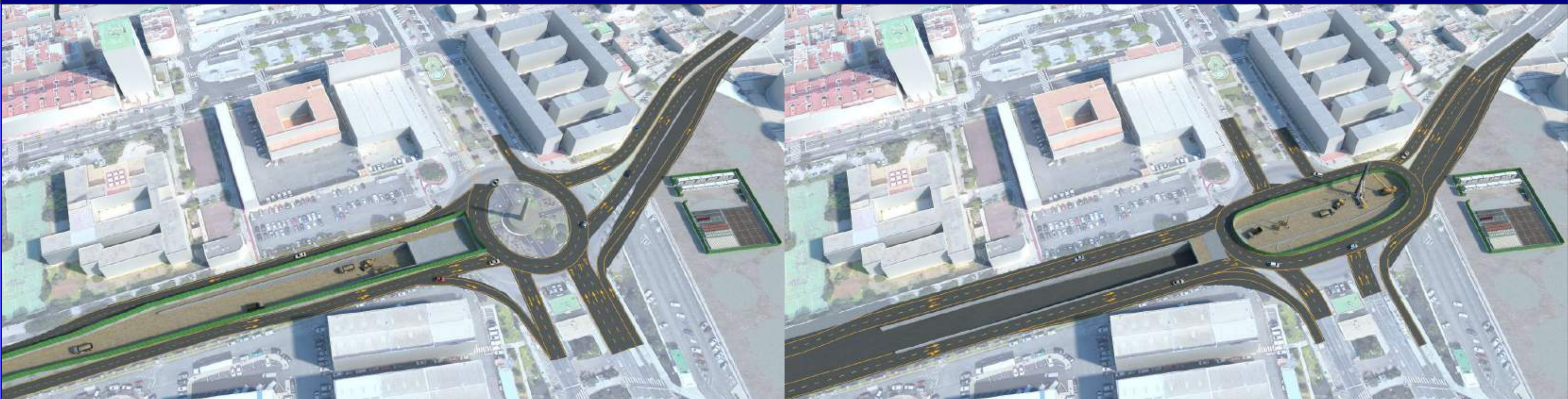
FASE 04: PANTALLAS EN ZONA ESTE. VACIADO DEL TÚNEL Y EJECUCIÓN DE LOSA INFERIOR
